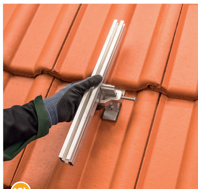
12b Die RAIL ausrichten und einhängen.
