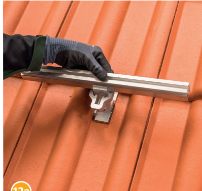
12a Die RAIL ausrichten und einhängen.
